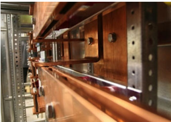
Một vài hình ảnh đồng thanh cái LiOA Some pictures of LiOA Busbar
