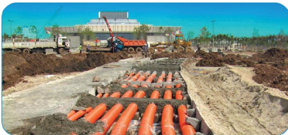
Hệ thống cáp ngầm tại các dự án đường dây cao thế 110 kV-220 kV Underground cable system at 110 kV-220kV power cable lines
